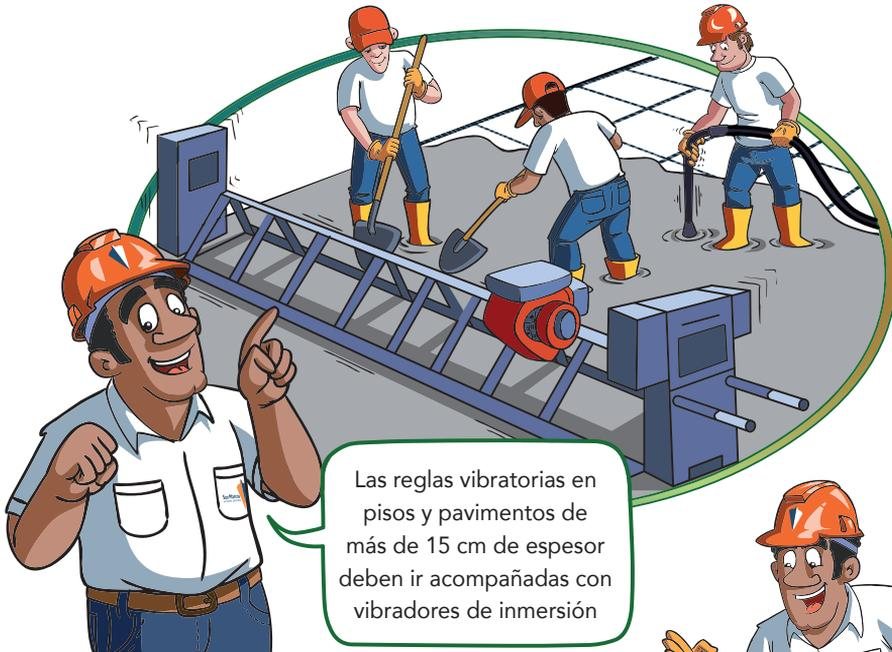
Las reglas vibratorias en pisos y pavimentos de más de 15 cm de espesor deben ir acompañadas con vibradores de inmersión
