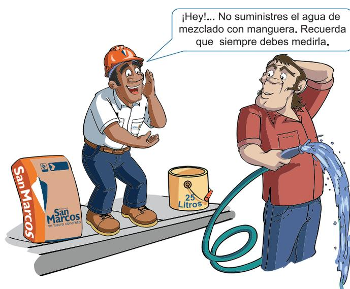
Recordemos que siempre se debe medir la cantidad de agua para la mezcla usando un máximo de 25 litros por cada bulto de cemento de 50 kilos; por otra parte, nunca se debe adicionar el agua con manguera ya que esto no garantiza la medida adecuada para obtener la correcta resistencia del concreto.
