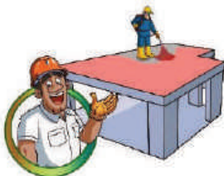
Aplicar películas curadoras
